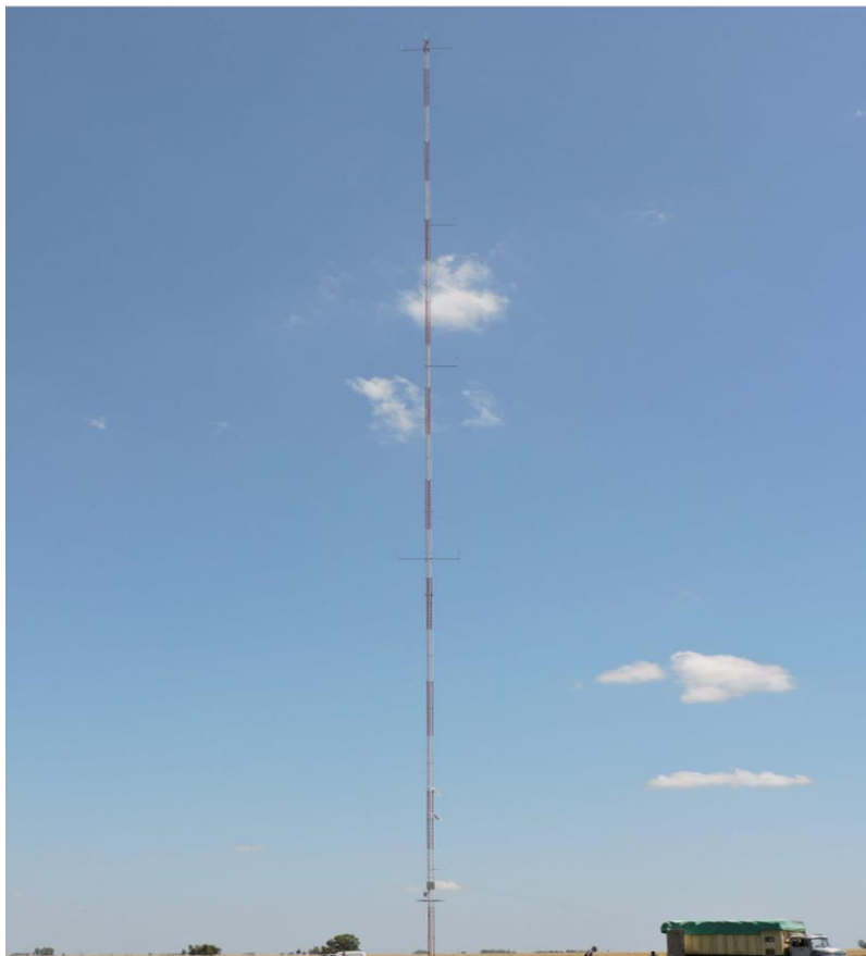
Imagen 10. Torre de medición de 120 m de altura, instalada en el sitio.
