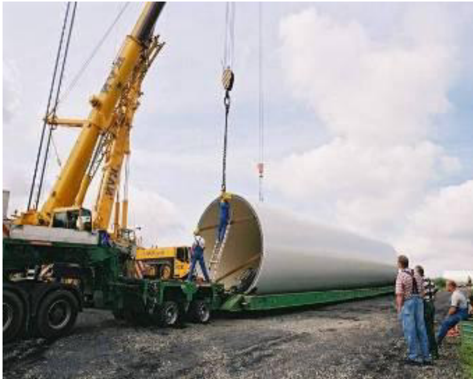
Imagen 21. Preparación para izaje de torre. Fuente WASA
