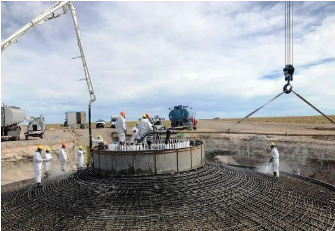
Imagen 20. Tareas de encofrado. Fuente WASA.
