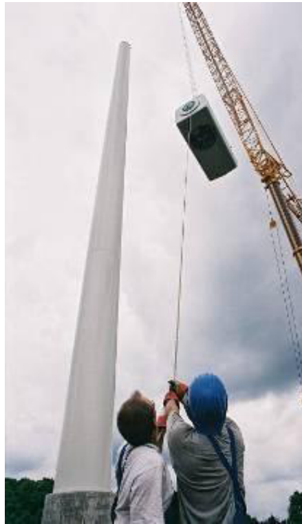
Imagen 23. Montaje de góndola. Fuente WASA
