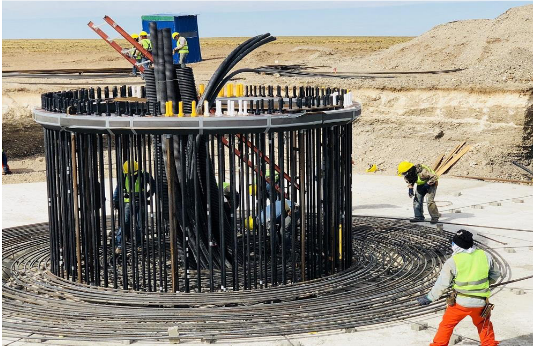
Imagen 19. Tareas de encofrado. Fuente WASA.
