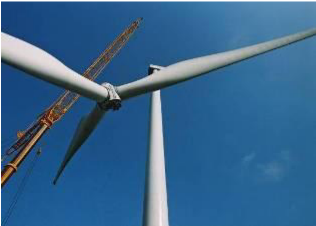
Imagen 24. Montaje de rotor. Fuente WASA
