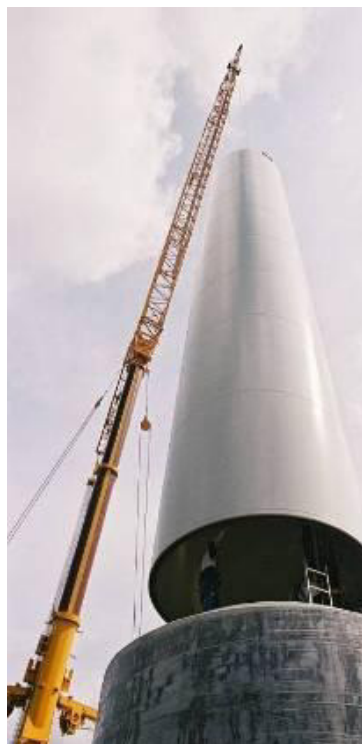
Imagen 22. Montaje de torre. Fuente WASA
